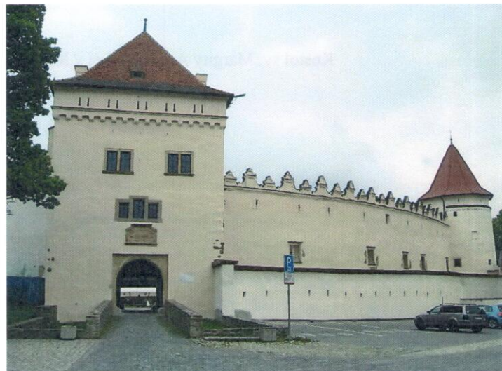
Ukončenie 1. etapy obnovy
